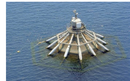
Figura 9. Actualmente é moi aventurado realizar en Galicia acuicultura en mar aberto pola súa alta enerxía. Exemplos de instalación experimentais capaces de soportar condicións de mar extremas (Tomado de: FAO. 2010)
