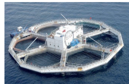
Figura 9. Actualmente é moi aventurado realizar en Galicia acuicultura en mar aberto pola súa alta enerxía. Exemplos de instalación experimentais capaces de soportar condicións de mar extremas (Tomado de: FAO. 2010)
