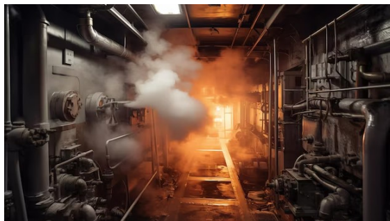
Incendio en sala de máquinas
