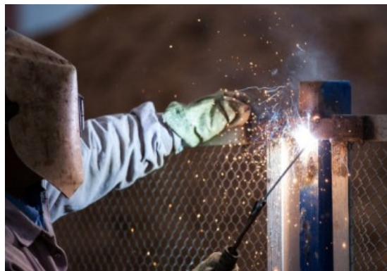
Soldadura por arco eléctrico
