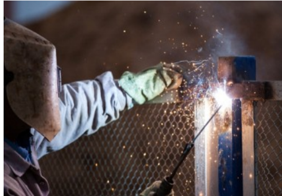
Soldadura por arco eléctrico
