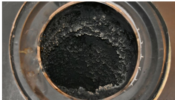
Acumulaciones de hollín en escape buque
