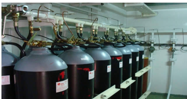
batería botellas del sistema fijo de CO 2
