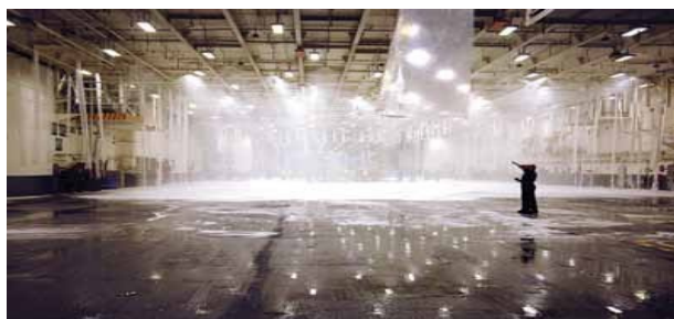
Sistema de tubería mojada
