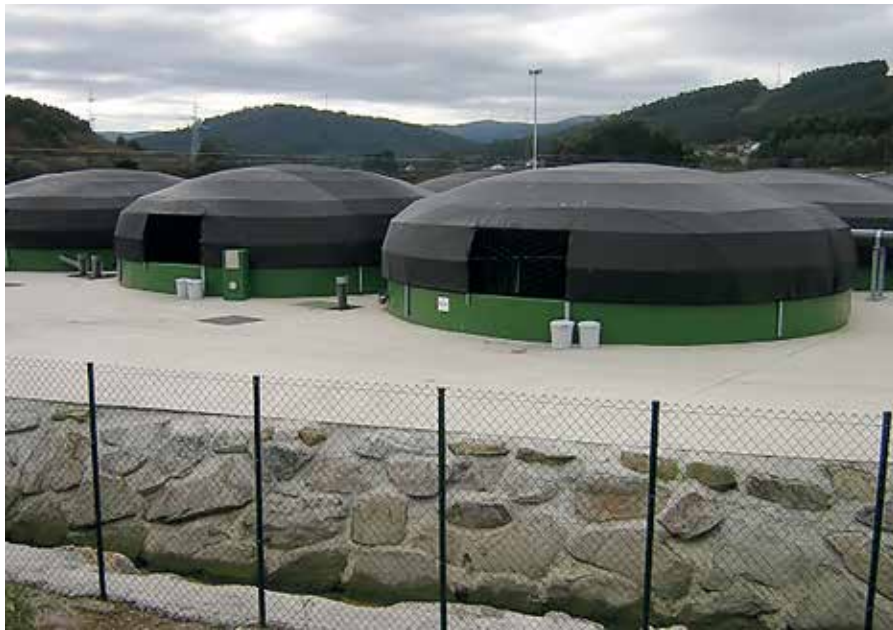
La cubierta permanente de los tanques de cultivo evita la depredación de peces o la introducción de patógenos por las aves.
