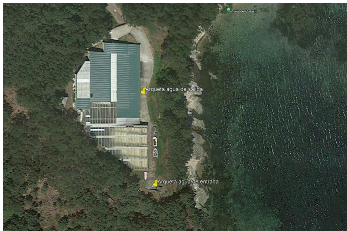
Fig 2. Localización de los puntos de recogida de muestras de agua para el control del Efluente.
