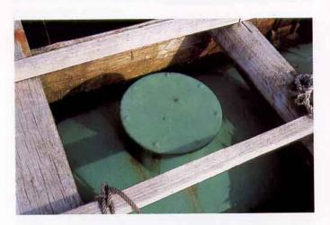
Flotador cilíndrico en la estructura del emparrillado.
