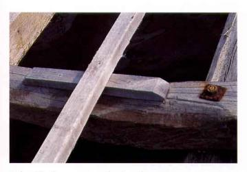
Sujección de un canco a la viga de través.
