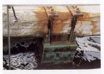
Sujección del flotador a la viga maestra
