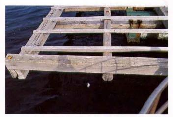
Detalle del emparrillado en que se observa las vigas de través, látigos y cancos.
