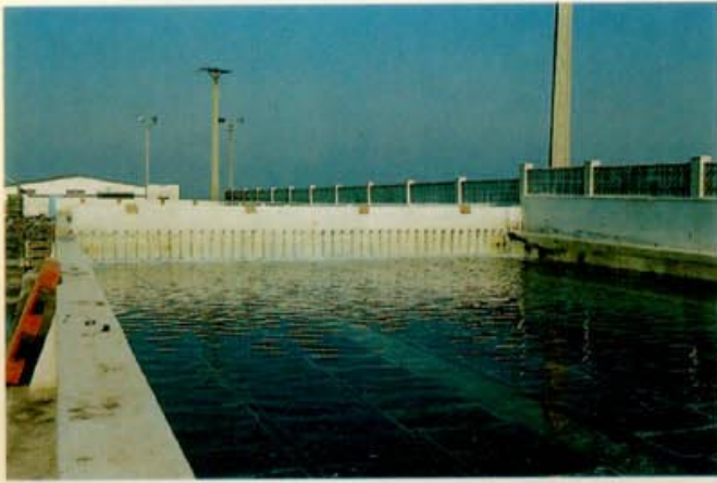
Piscina en depuración
