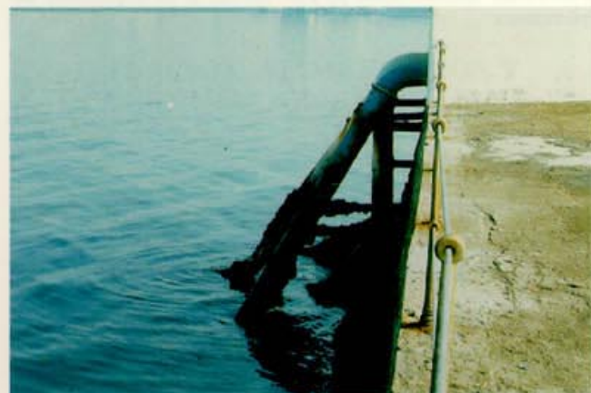
Para evitar las capas de agua dulce las depuradoras disponen el punto de toma del agua marina a varios metros de profundidad.
