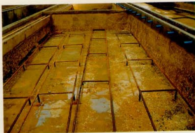
Disposición de un emparrillado metálico sobre el fondo de la piscina
