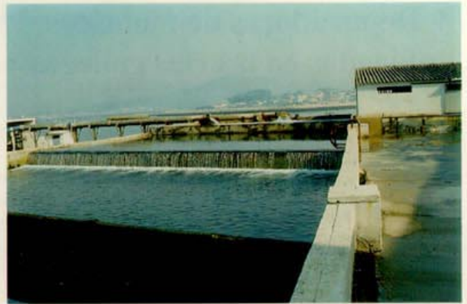
Tanque de contacto del elemento depurador con el agua de mar y posterior eliminación.
