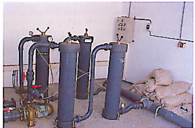
Equipo de filtración industrial con carcassas dispuestas en series de dos, para filtro de cartucho.
