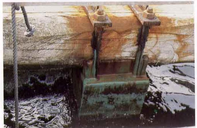
**Sujeción del flotador a la viga maestra**
