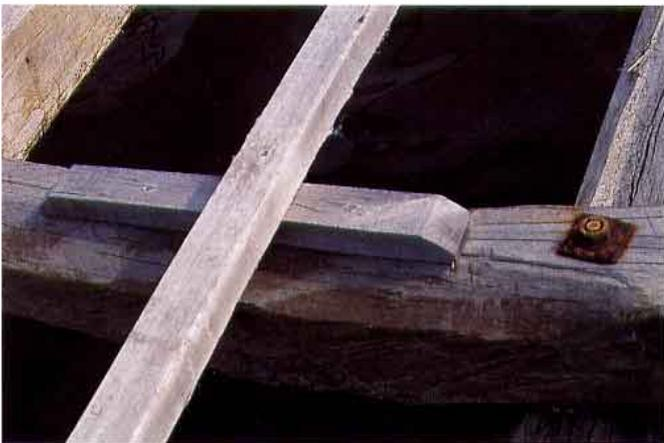
**Sujección de un canco a la viga de través.**
